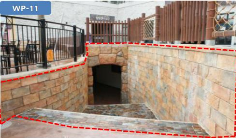
실외 워터파크 화장실 진입 외벽
